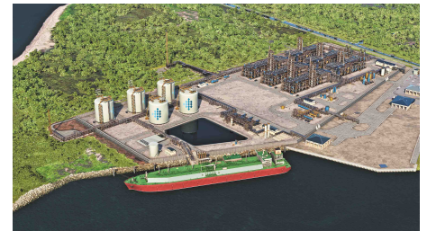
Technip Energies Commonwealth LNG
